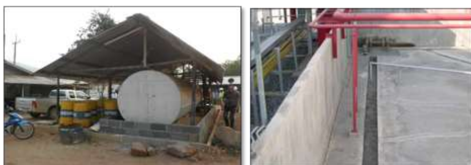
รูปที่ 7.2.1-3 การเทพื้นคอนกรีตในบริเวณที่อาจเกิดการรั่วไหลของน้ำมันและไขมัน
