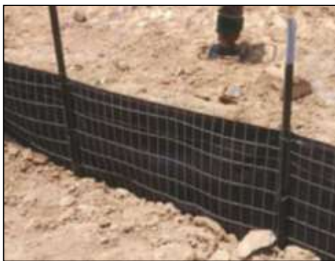
รูปที่ 5.3.2-2 ตัวอย่างรั้วทึบชั่วคราวป้องกันไม่ให้สัตว์เลื้อยคลานประเภทบกกลุ่มงูและสัตว์เลื้อยคลาน
