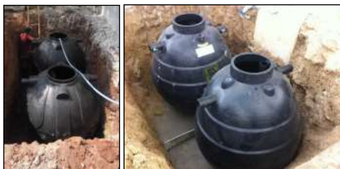
รูปที่ 7.2.1-4 ตัวอย่างถังบำบัดน้ำเสียสำเร็จรูป
