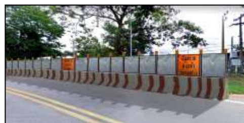
รูปที่ 7.2.2-1 ตัวอย่างรูปแบบกำแพงกันเสี่ยงชั่วคราวที่นำมาใช้ในกิจกรรมก่อสร้างโครงการ
