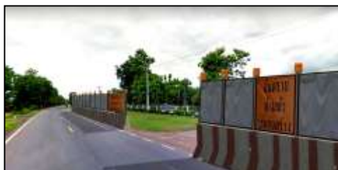
รูปที่ 7.2.2-1 ตัวอย่างรูปแบบกำแพงกันเสี่ยงชั่วคราวที่นำมาใช้ในกิจกรรมก่อสร้างโครงการ
