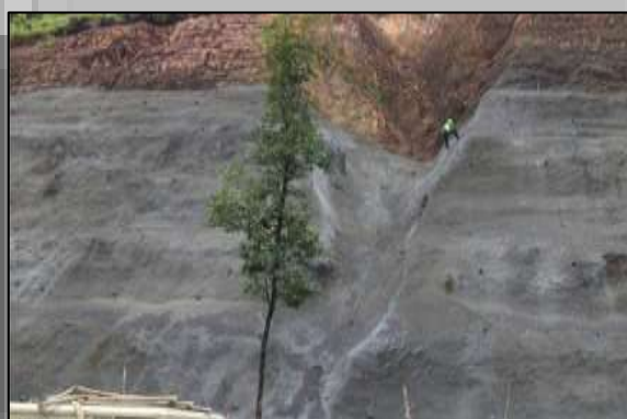
รูปที่ 5.3.1-1 ตัวอย่างการฉาบผิวด้วยซีเมนต์ (Shotcrete) ป้องกันการกัดเซาะของดิน
